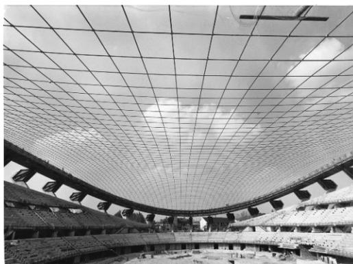
Le funi metalliche a sostegno della struttura del tetto
